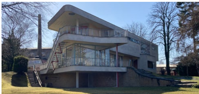
Die Bauhausvilla „Haus Schminke“ in Löbau
